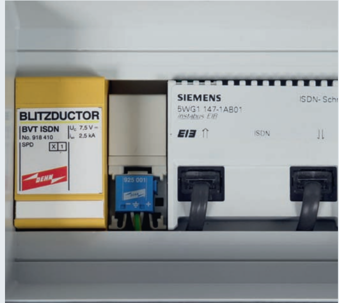
Ograniczniki przepięć do EIB / KNX z wyprowadzonymi przewodami
