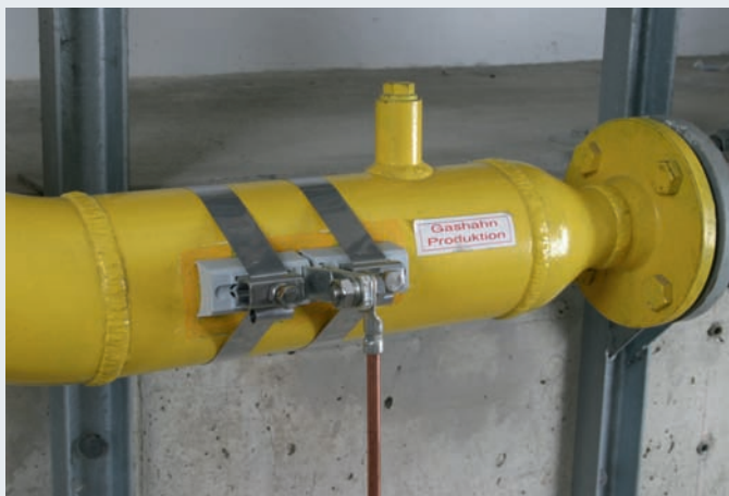
Obejma taśmowa na rurę zapewniająca kontakt elektryczny w strefie Ex, do stosowania jako element wyrównania potencjałów wg PN-EN 62305-3
