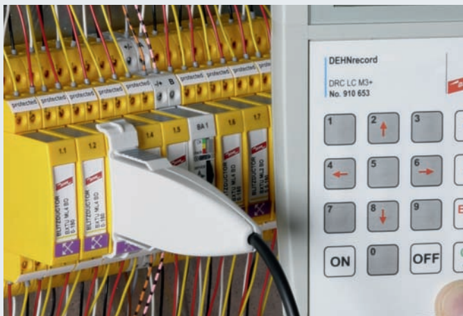
Kontrola modułu ogranicznika ze znacznikiem RFID
