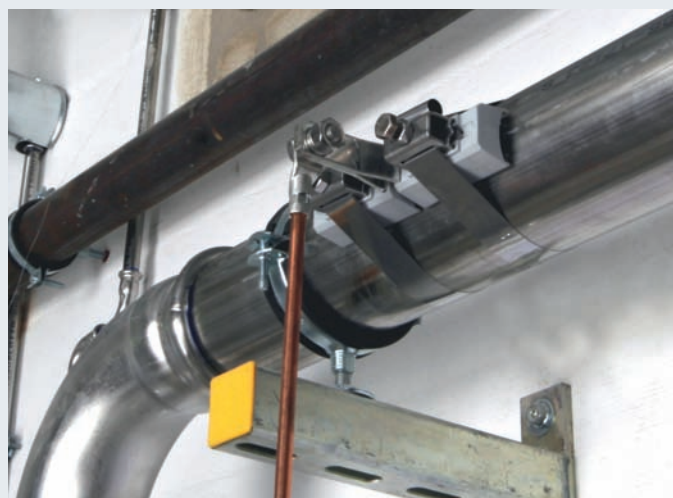
Zastosowanie obejm na rurze ze stali nierdzewnej NIRO
