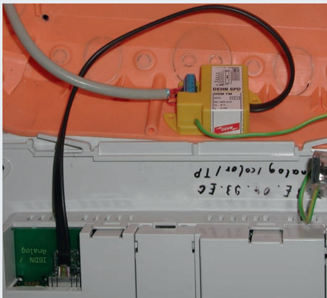
Ogranicznik przepięć do montażu podtylnkowego w sieci LAN.
