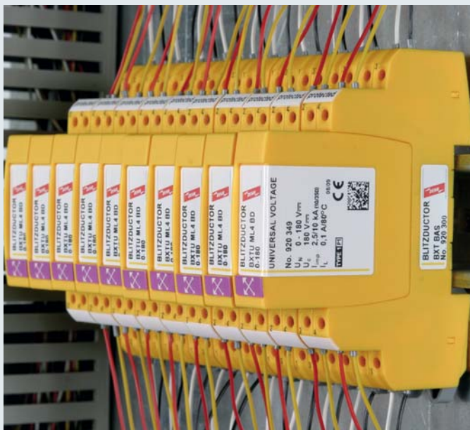
Grupa BLITZDUCTOR XTU zastosowana w instalacji.
